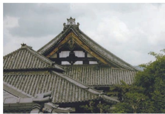
本堂(奥)と祖師堂(手前)の屋根
