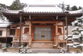
平成21年11月1日 本堂新築落成
