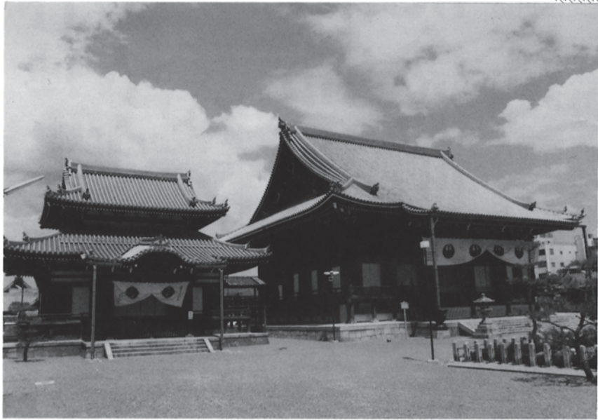
“昭和の大修繕”で大屋根全面修復になった本堂・開山堂
