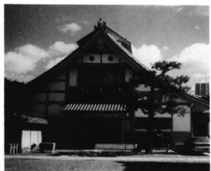
全面改築新装になった大玄関
